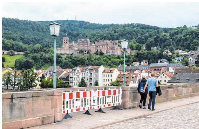
Rot-weiße Absperrgitter vor drei Balkonen: Bereiche der Alten Brücke sollen am 1. September noch einmal genau überprüft werden. BILD: PHILIPP ROTHE
